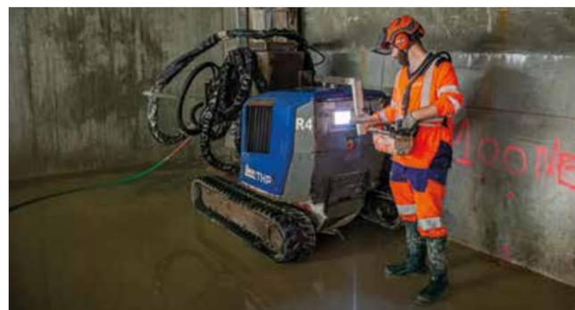
Mais avec passion l'équipe s'est attelée à retirer au robot les 7 cm de béton de la structure détériorée et réaliser un décapage surfacique des box à la lance. Cette intervention a été couplée d'un traitement des eaux en continu, avec quelques déboires mais très vite canalisés.
